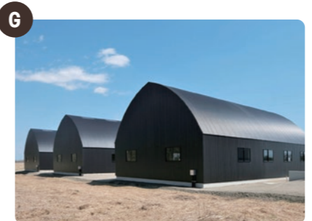
G 実習棟 - 外観 日本全国の掘削企業にご協力いただき、実際に掘削現場で利用する機械を用いて実習を行います。大型の機械を扱うため安全管理学習にも力を入れており、危険な状況を体感できる設備も導入し授業を行っています。
